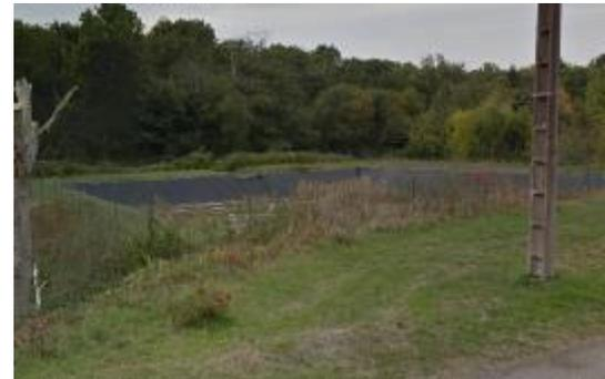
Photo d'un bassin tampon aménagé à Soulvache à proximité du captage de Bonne fontaine, pour piéger les hydrocarbures en cas d'accident
